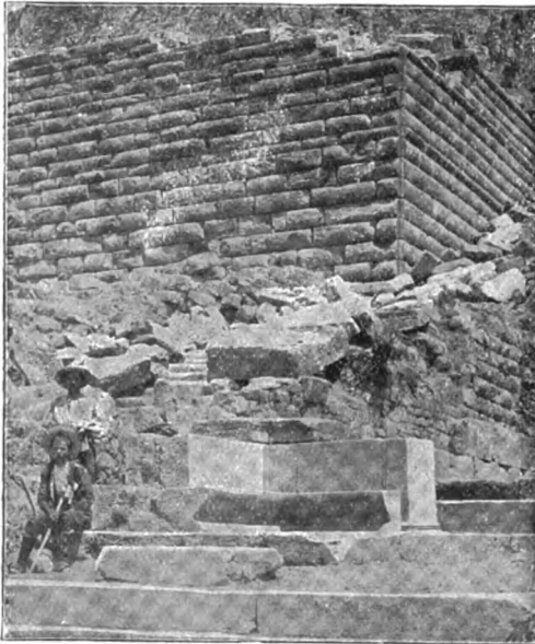
663. Stützmauer in Priene
